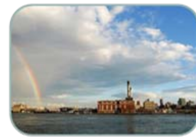
συμπαράγωγή ηλεκτρισμού και θερμότητας υψηλής απόδοσης
